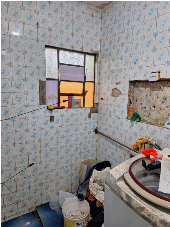
BANHEIRO: REMOÇÃO DE ESQUADRIA EXISTENTE E INSTALAÇÃO DE NOVA ESQUADRIA
